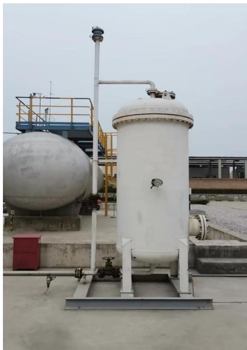
图 4.1-2 油气回收装置
