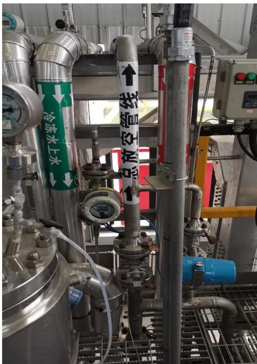
图 4.1-1 火炬放空管线
